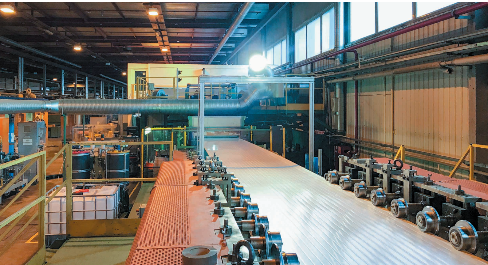
Завод стеновых и кровельных сэндвич-панелей с PIR (ПИР), линия профилировки и кромкогибки PIR-панелей
